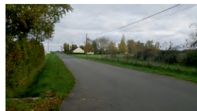
La rue des Bezeaux avant travaux
